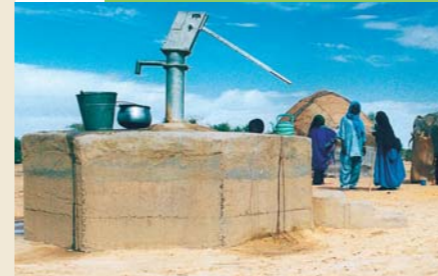
Source SOS SAHEL Légende : Fermer les puits permet de protéger les nappes d'eau des souillures et de sécuriser leur utilisation.
